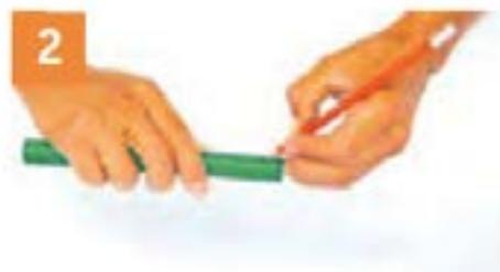
Asegúrese de marcar la inserción del tubo para evitar introducir excesivamente y causar obstrucción en la unión.
